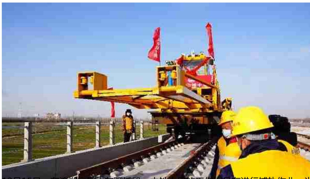
12月15日，在济郑高铁山东聊城段，中铁十局的工作人员在进行铺轨作业。当日，济（南）郑（州）高铁（山东段）铺轨开工仪式在聊城举行，随着第一对长500米的钢轨缓缓入槽，标志着济郑高铁（山东段）开启全面铺轨建设。新华社记者郭绪雷 摄
