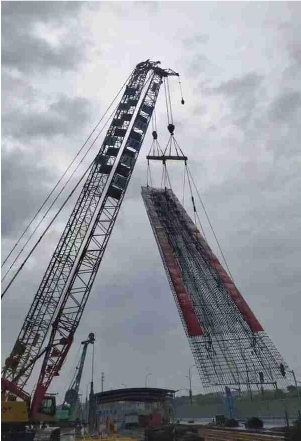
为保证首幅地连墙钢筋笼顺利吊装，崇明线建设单位会同施工单位精心组织召开了地连墙钢筋笼吊装专项方案论证会、安全技术交底会，科学规划吊装方案以及人员、材料及机械配备，严格落实各项安全质量管控措施，开展隐患大排查，从严从细从实强化安全管理。
