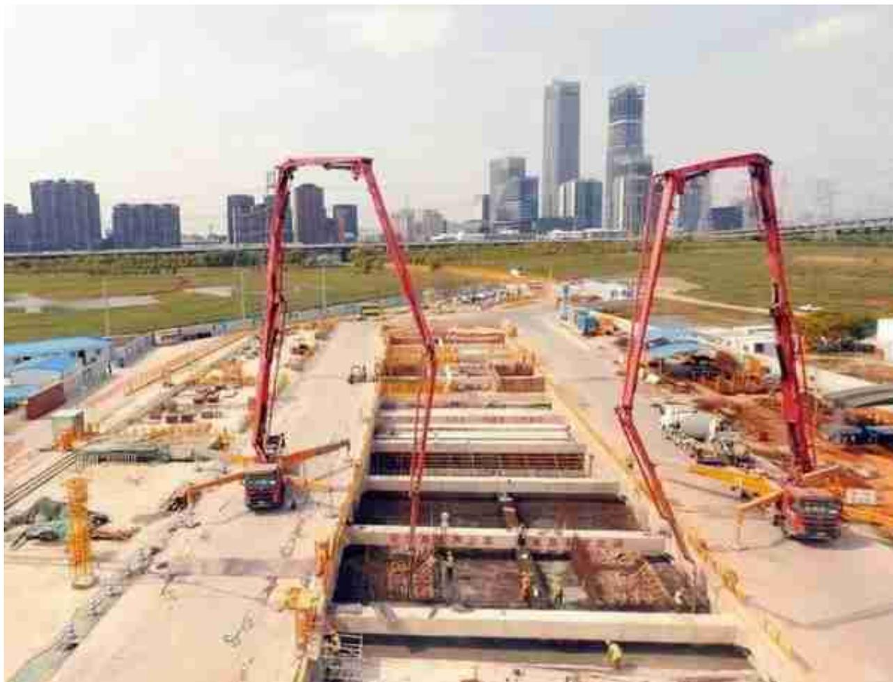
近日，随着21号线4标军民路站最后一块顶板630立方米混凝土浇筑完成，由上海公路桥梁（集团）有限公司承建的21号线一期工程土建4标军民路站顺利完成主体结构封顶，该车站也成为线路上首座主体结构封顶的车站。
