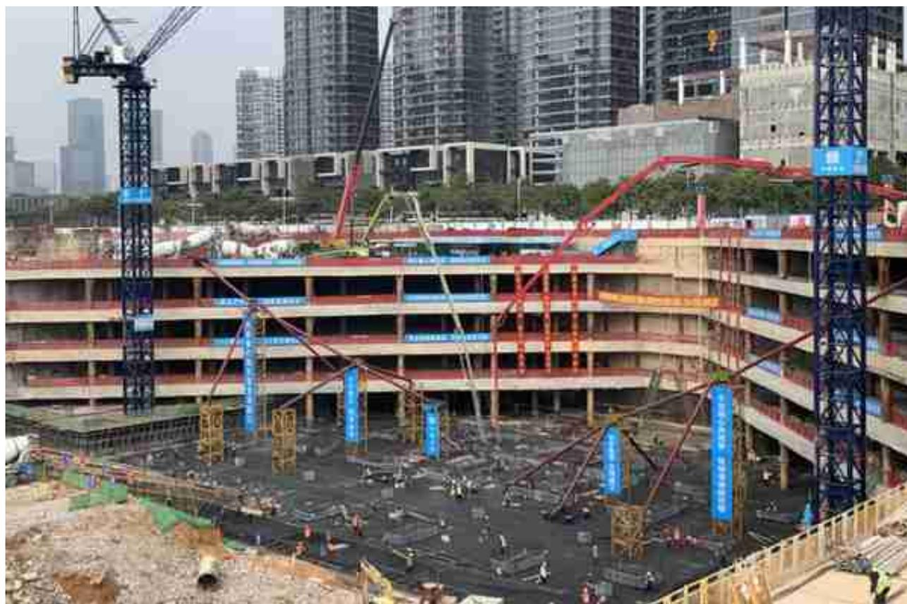
项目首块主塔楼底板长约76米，宽约50米，混凝土单次浇筑达1.3万立方米。由于内支撑及基坑底场地狭小，天泵+地泵浇筑方式无法满足施工需求，项目团队精细研究，设计并采用多角度溜管+溜槽+天泵浇筑综合施工技术，布置2套溜管、2条溜槽、2台天泵，平均每小时可浇筑360立方米，在36小时内完成了大底板浇筑，且溜管、溜槽浇筑过程无噪音，材料可周转，在进度、安全、质量、绿色施工等各方面均取得良好效果。
