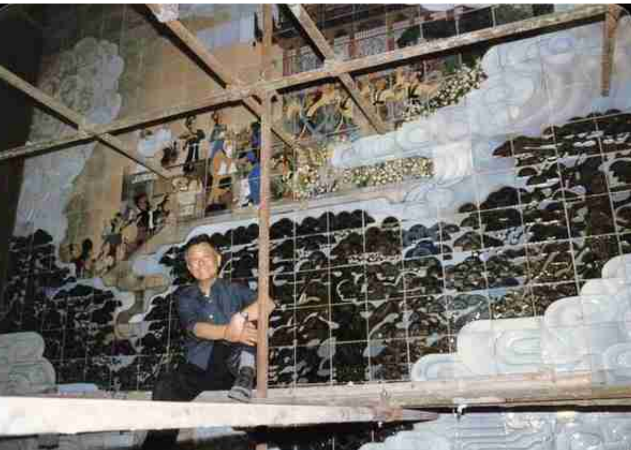
1986年，周令钊先生在高9米宽5米的陶板高温花釉壁画《白云黄鹤》武汉黄鹤楼安装现场
